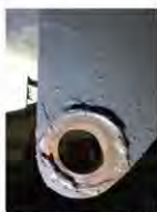
Imaginea 6 – sudura de fixare a bulonului era ruptă, cu ruptură parțial veche.
