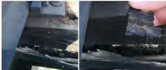
foto nr.17 - traversă crăpată la partea inferioară, în interior materialul din care este confecționată traversa are aspect de lemn carbonizat
