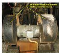
Fig. 7 Grup ventilație forțată motoare de tracțiune post nr.2 de conducere
