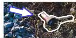
Imaginea 5 - Bulon și braț de la brida pendulară, găsite pe terasamentul căii ferate
