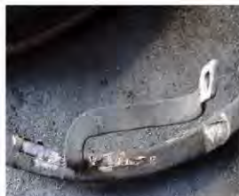
Foto nr.4 izolația carbonizată pe bara de însereare
