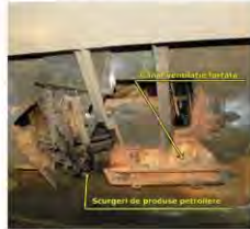
Fig.10 Scurgeri de produse petroliere în zona cutiei de borne și canalul de ventilație la MET nr.4
