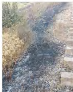
Fig. 3 Vegetație arsă până în capătul traverselor
