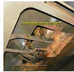
Fig. 11 Cablurile de forță, de inseriere, de la canalul de cabluri la MET nr.4
