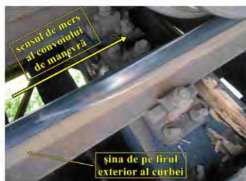
foto nr. 9 - urmă de rulare a buzei bandajului roții din partea dreaptă, pe ciuperca șinei de pe firul exterior al curbei
