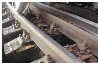
foto nr. 11 - capete de traverse de lemn special pentru poduri rupte, dar cu prinderi active
