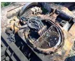
Foto nr.7 cablurile de alimentare cu izolația arsă
