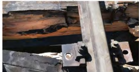
foto nr. 7 - traversă care la interior are aspect de lemn carbonizat
