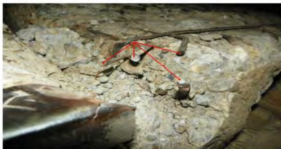
foto 4: secțiunea de rupere a armăturilor pe zona desprinderii platbandei metalice
