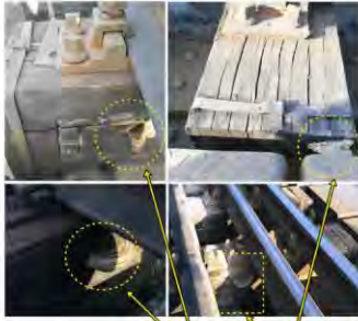
ciuperci care s-au format și au crescut în interiorul traverselor
