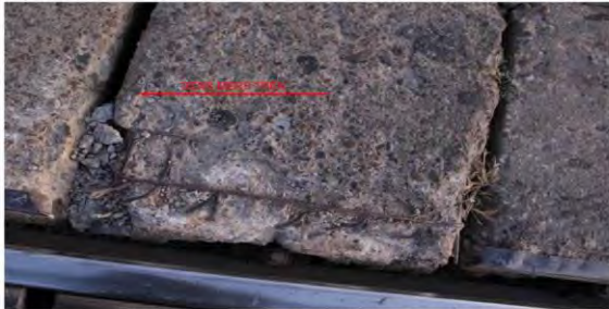
foto 2: plătbanda metalică lipsă la antepenultima dală a trecerii la nivel
