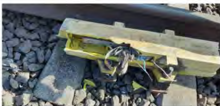
Imaginea nr.6 - Inductor de cale avariat
