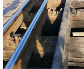
foto nr. 16 - traverse cu crăpături longitudinale
