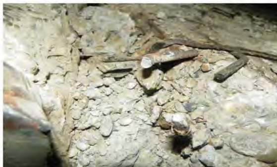
foto 11: starea secțiunii de rupere a armăturilor aflate la capătul dalei dinpre Roșiori, după impact
