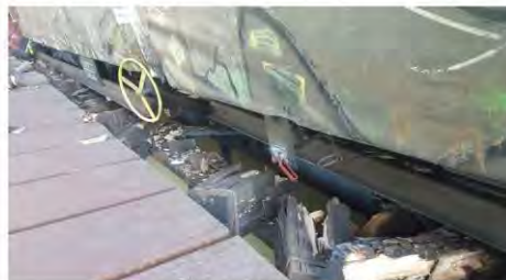
foto nr. 5 - capete de traverse rupte
