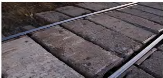
foto 3: urme de frecare pe suprafața superioară a ultimilor 3 dale precum și platbanda metalică lipsă la antepenultima dală din cuprinsul trecerii la nivel
