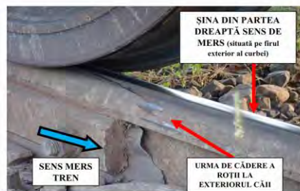
Fotografia nr.4 Locul căderii roții din partea dreaptă, în exteriorul căii
