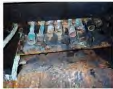
Foto nr.2 conectorii tip tulipă (M) din blocul S4
