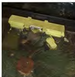
Imaginea 3- Avarie la inductorul de autostop din cale de 1000/2000 Hz aferent semnalului XR de pe BLA Călărași Turda – Câmpia Turzii. Cutia cu borne este smulsa din corpul inductorului.
