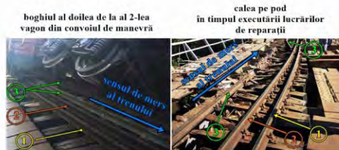
foto nr. 4 – pe fețele superioare ale grinziilor de lemn nu sunt urme care să indice deplasarea plăcilor metalice
