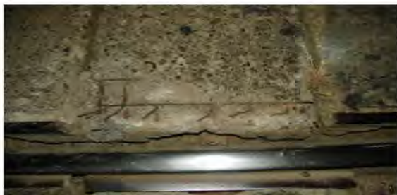
foto 10: starea secțiunii de rupere a armăturilor de fixare a platbandei metalice (cadru general)
