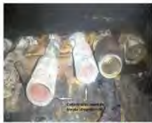
Foto nr.1 conectorii tip tulipă (M) din blocul S4
